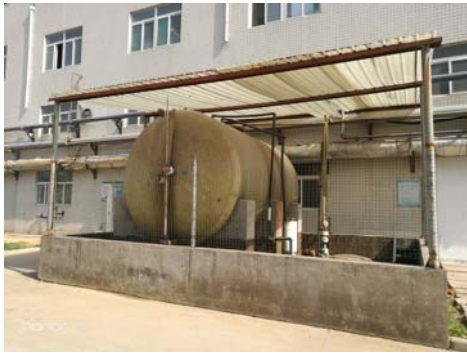
盐酸罐区围堰
