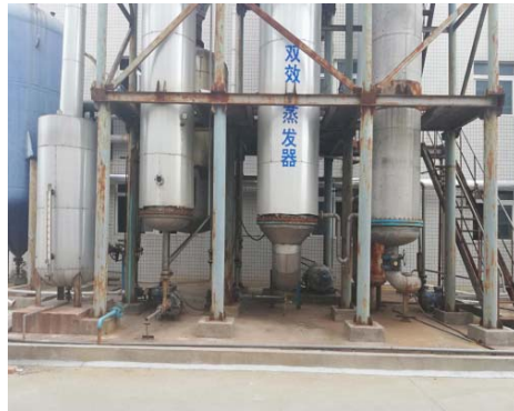
双效蒸发器区域防渗处理
